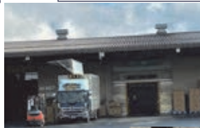
信州名鉄運輸株式会社 北信濃営業所冷蔵倉庫
