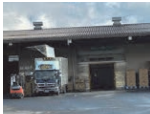
長野県中野市・名鉄運輸株式会社北信濃営業所冷蔵倉庫
