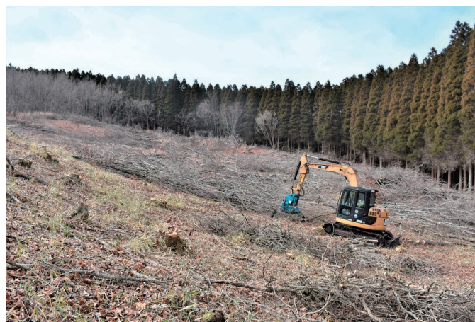
奥に見えるのが重機によって一定方向に並べられた原木
