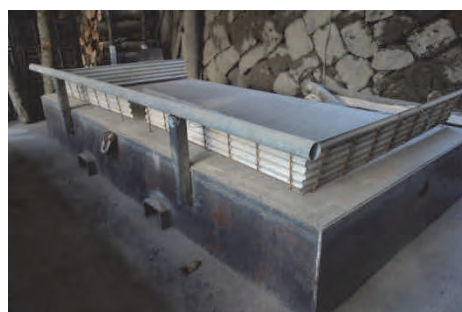
遮熱板、かすり、シャックルを設置
