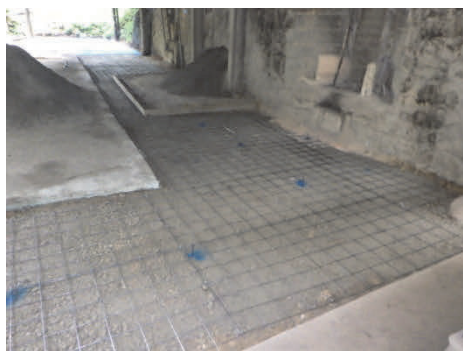
ワイヤーメッシュ施工
