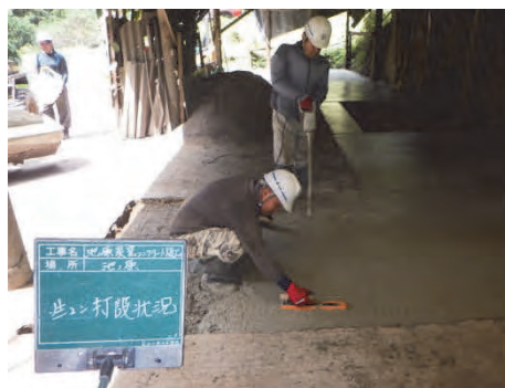
コンクリート打設状況
