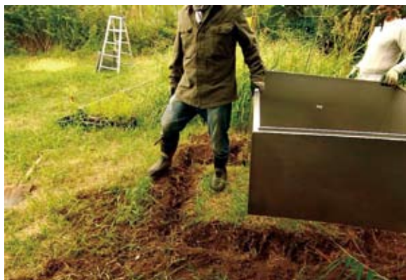
図Ⅲ -26 炭化炉の設置は2名以上で行うことが望ましい
