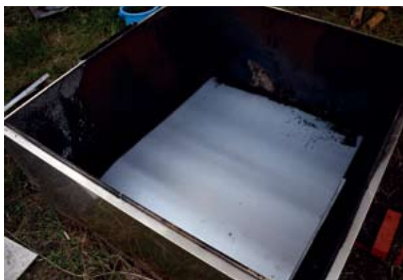
図Ⅲ -28 窯底にガルバリウム鋼板を敷き保温を図る
