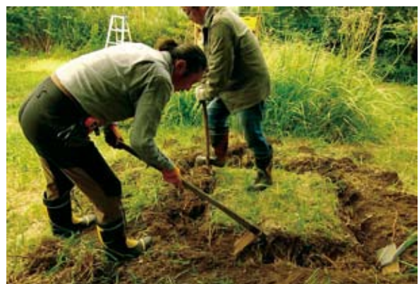
図Ⅲ-25 炭化炉の接地部分を掘り下げ空気を遮断する
