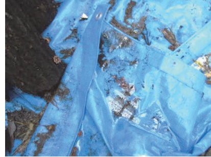
写真4 ブルーシートに雨水が溜まった状態
