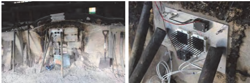
<炭窯入口 機器設置状況>
