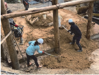
【窯天井部築固め仕上げ】
