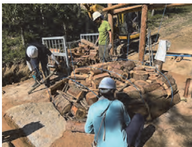
【窯天井部の土築固め】
