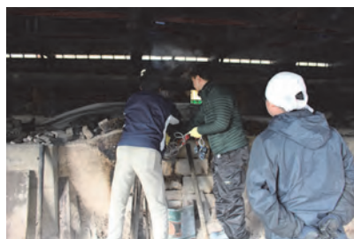
炭窯への設置作業
