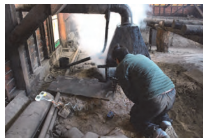
煙突側での設置作業
