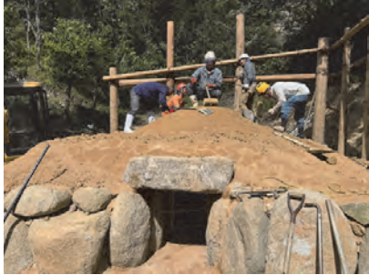
【窯天井部築固め仕上げ】
