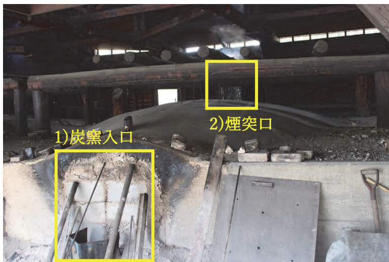
<炭窯全体（斜め前側より撮影）>
