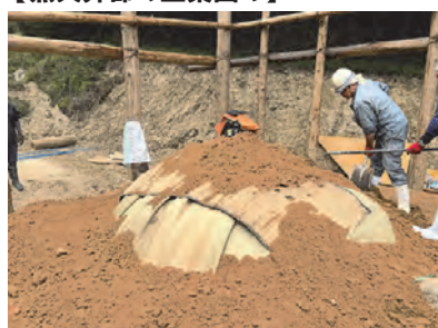
【窯天井部の土築固め】
