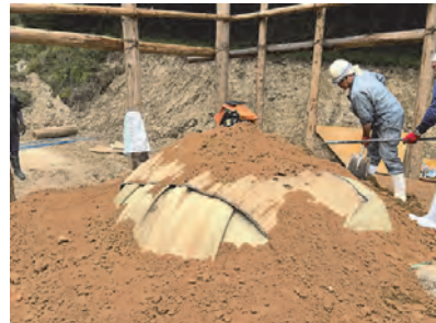
【窯天井部の土築固め】
