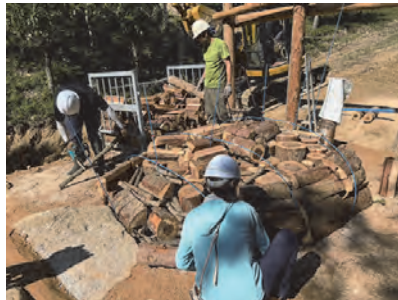
【窯天井部の土築固め】
