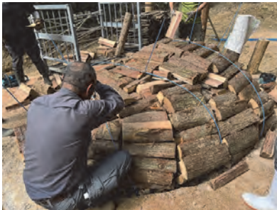
【窯型の天井部仕上げ】
