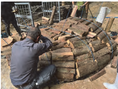
【窯型の天井部仕上げ】
