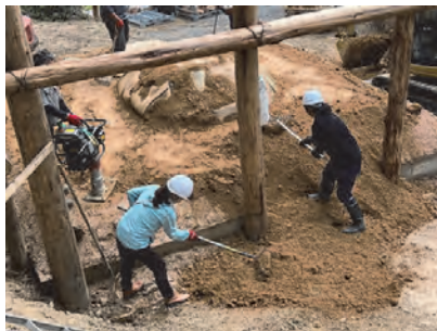
【窯天井部築固め仕上げ】
