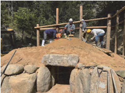
【窯天井部築固め仕上げ】
